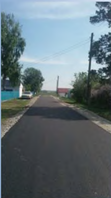
Ремонт дома дороги в с. Дружба 1,6 млн. руб.
